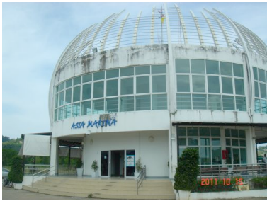
【写真-4】 ジブシー村付近のマリーナ施設
