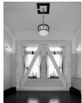
当時の雰囲気を残した耐震補強
