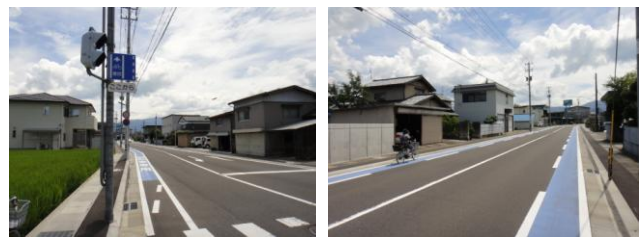
写真 - 2 自転車専用通行帯設置区間の一部区間
