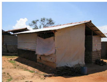
写真-2 仮設住宅
