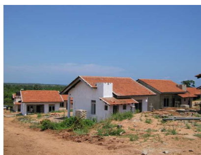
写真-5 Konesapuriの恒久住宅建設現場
