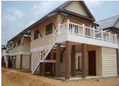
図-11 パーンタップラム恒久住宅地
