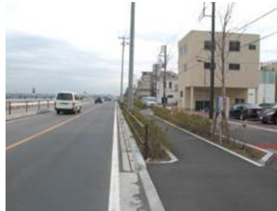
写真-4 スーパー堤防整備後
