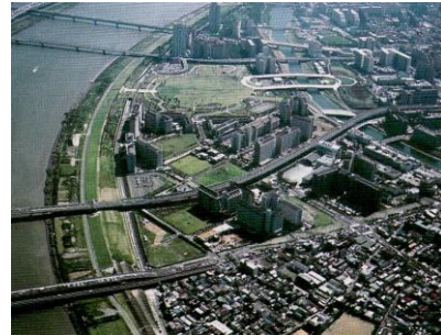
写真-7 スーパー堤防整備後
