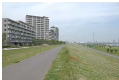
写真-2 スーパー堤防整備後
