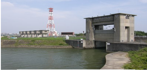
写真3 江戸川水閘門
