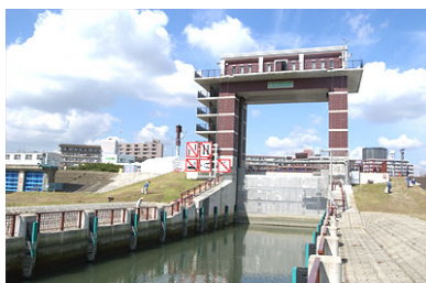
写真1 荒川ロックゲート
