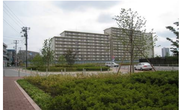
写真-5 葛飾新宿六丁目地区内に整備された広幅員歩道の状況
