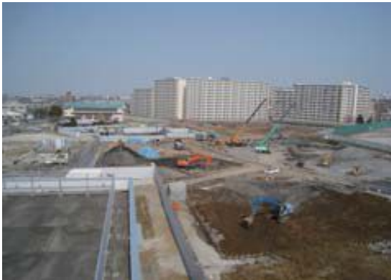
写真-3 葛飾新宿六丁目地区の工場の撤去中の状況
